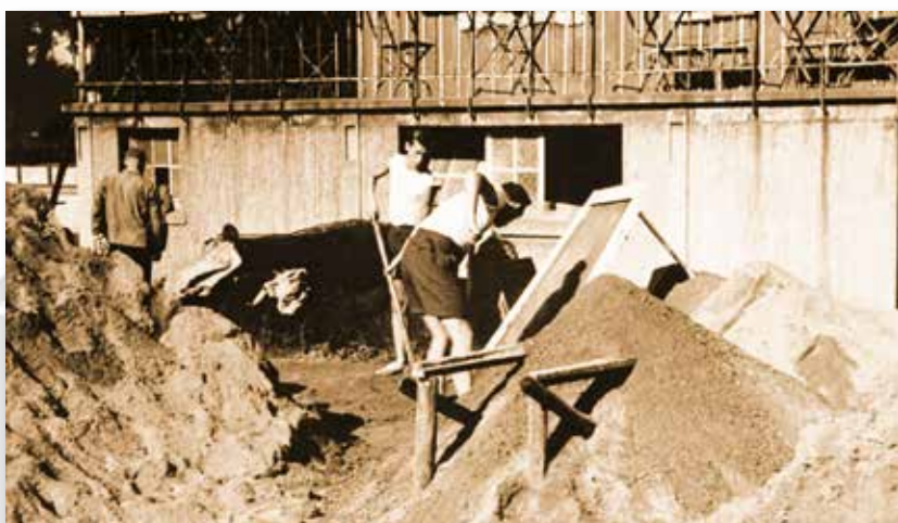
Tenisści przy odbudowie kortów po powodzi, 1958 r.
